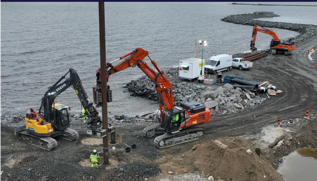
Stålpålar installeras samt iskydd
