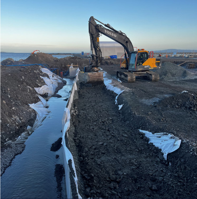
Noden montage av L-stöd för kommande trallyta.
