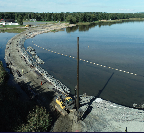
Pålningensmaskin installerar stålpålar
